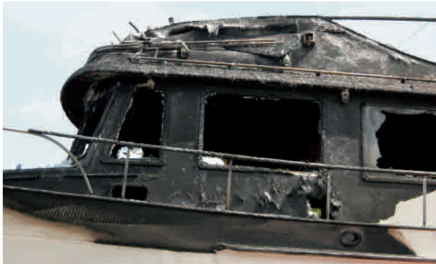
Totaler Brandschaden durch ein Feuer auf der Nachbar-Yacht.
